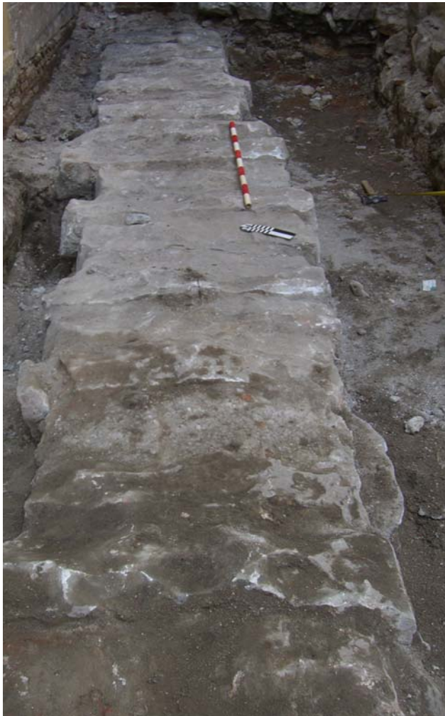
Figura 5. UE 105, Coberta de la claveguera..
