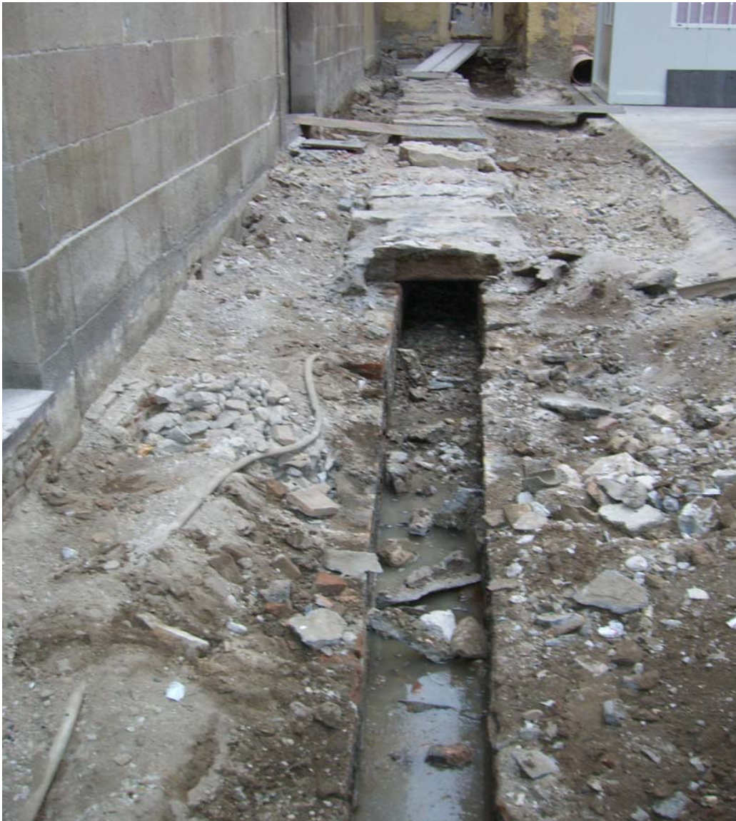
Figura 6. Interior de la claveguera.
